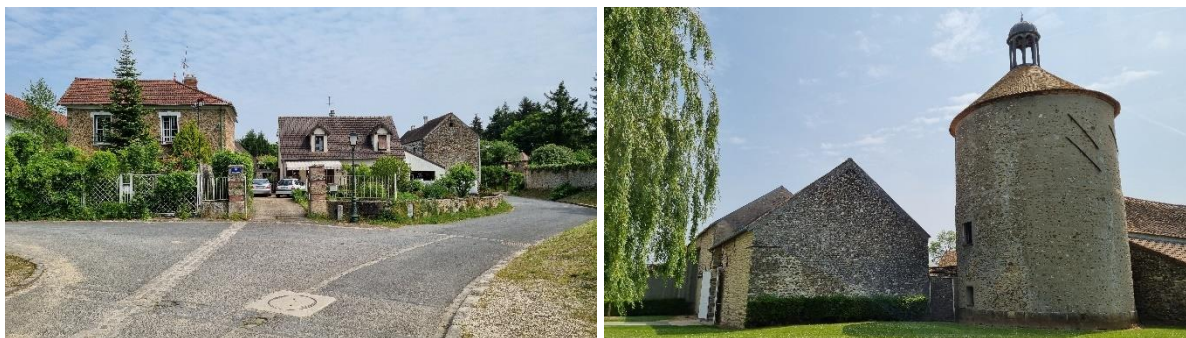
Bâti en centre-bourg en UA (à gauche) et du Fresneau en UF (à droite)
